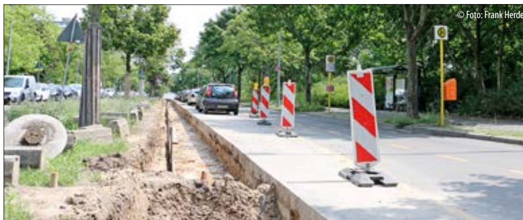
Baumaßnahme – Neuer Radweg auf der Fahrbahn am Kölner Damm
