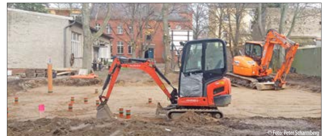
Bauvorbereitungen für das Fundament der Baumaßnahme Seniorentagesstätte in Alt-Rudow
