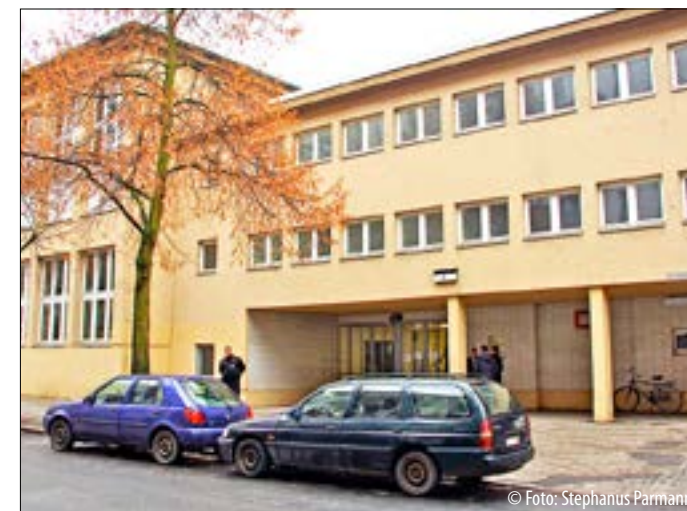
Seit Januar 2016 hat die VHS in der Boddinstraße 34 ein eigenes Gebäude
