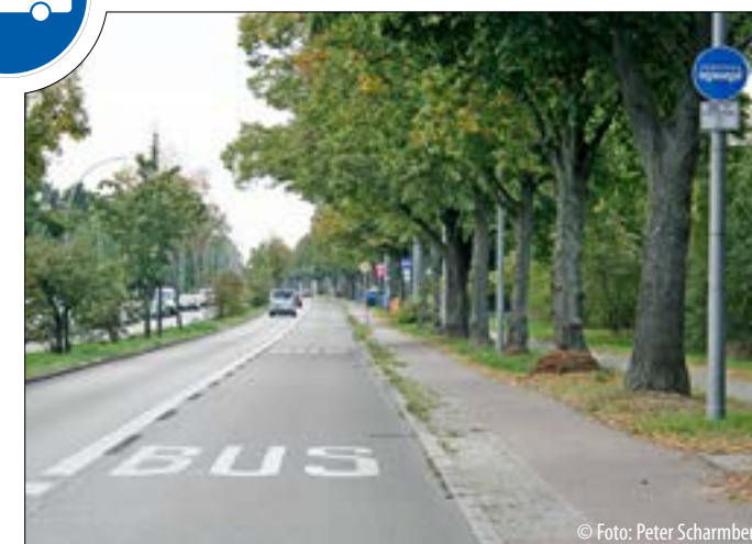
Busspur auf der Waltersdorfer Chaussee stadteinwärts Richtung Rudow
