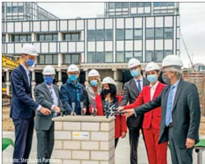
Grundsteinlegung für Berlins größten Krankenhaus-Erweiterungsneubau
