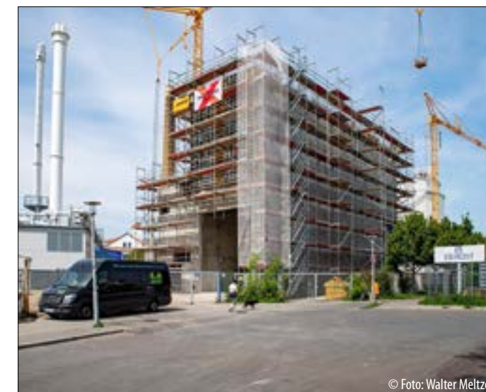
Neues Blockheizkraftwerk im Bau
