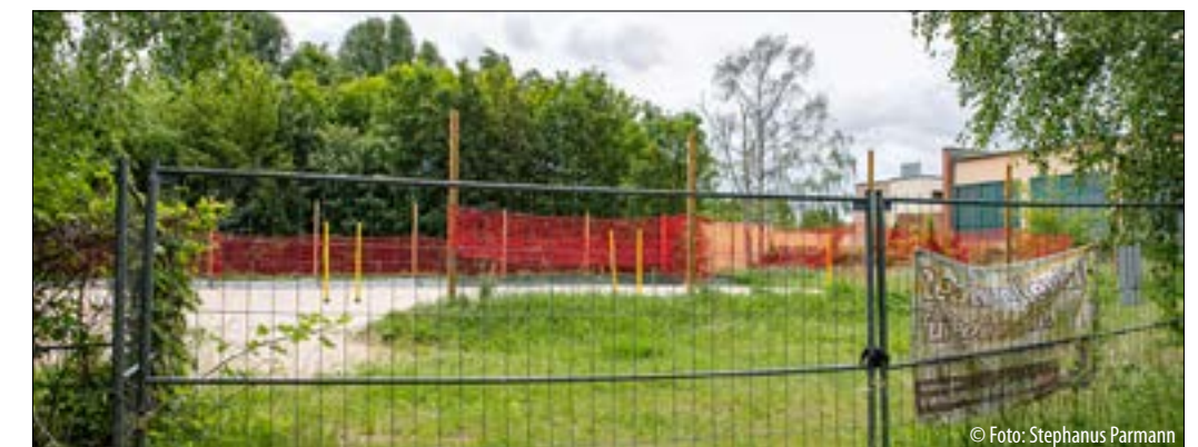
Auf dem Beachvolleyballplatz entsteht das neue Schulgebäude – Eine neue Beachvolleyballplatzanlage wird gebaut
